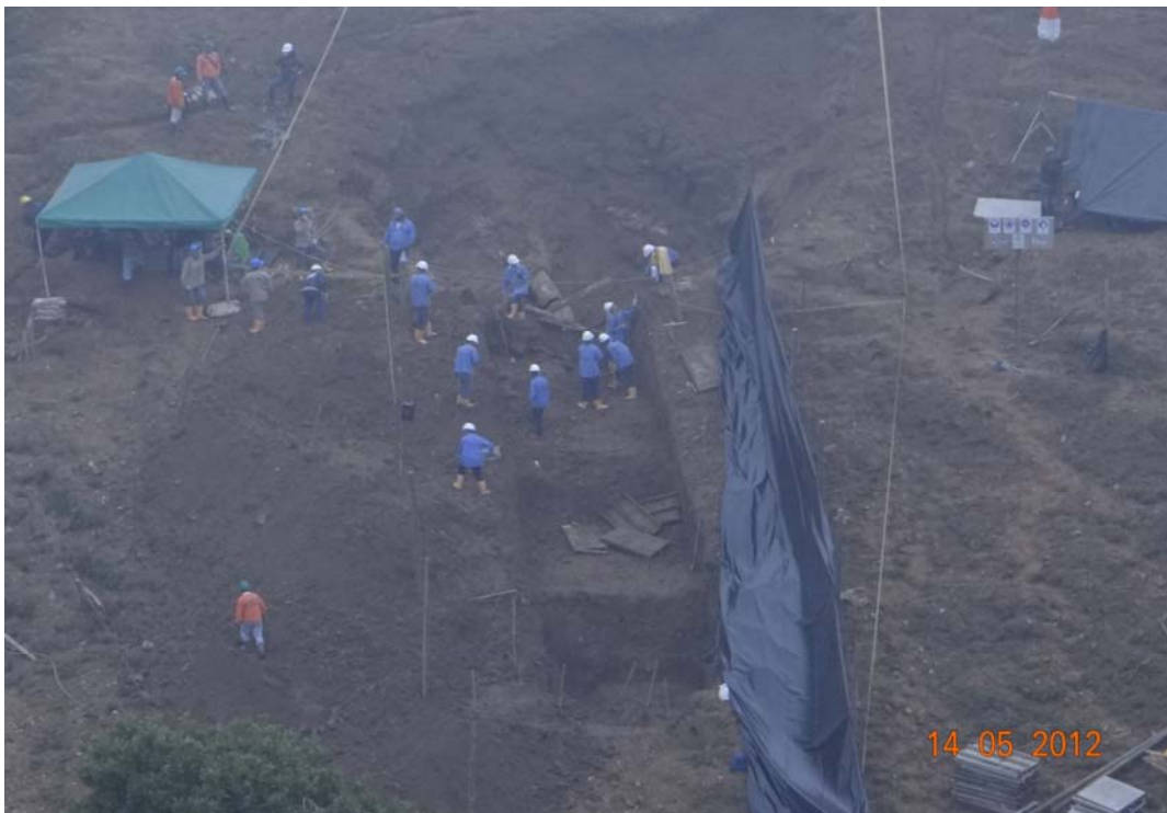
AVANCE DE EXCAVACIONES SOBRE EL DERECHO DE VÍA
