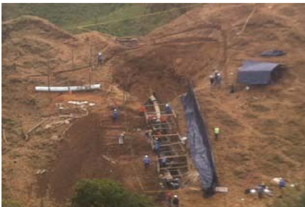
AVANCE DE LAS EXCAVACIONES SOBRE EL DERECHO DE VÍA
