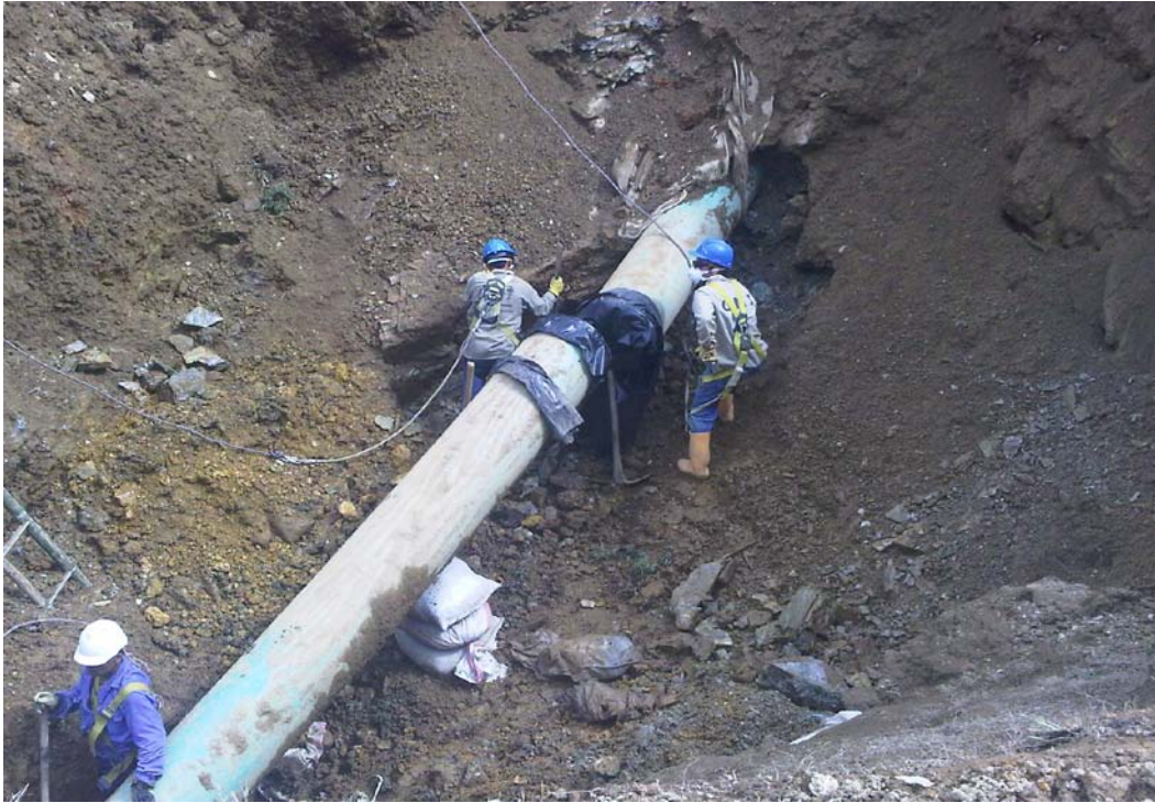
AVANCE DE LAS EXCAVACIONES SOBRE EL DERECHO DE VÍA
