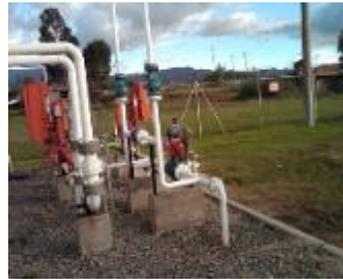
Punto de salida, sin caja de inspección y actuador.
