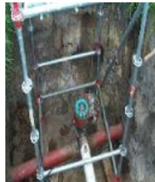
Disposición para realizar la perforación en un accesorio e va a sacrificarse.
