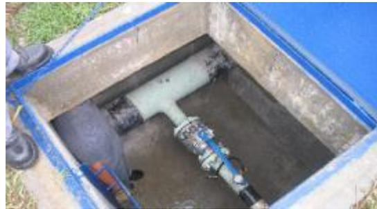
Caja de inspección con su derivación
