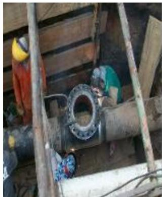
Split tee con brida. Proceso de soldadura.
