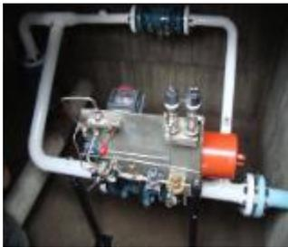
Accesorio hot tap, derivación con by pass.
