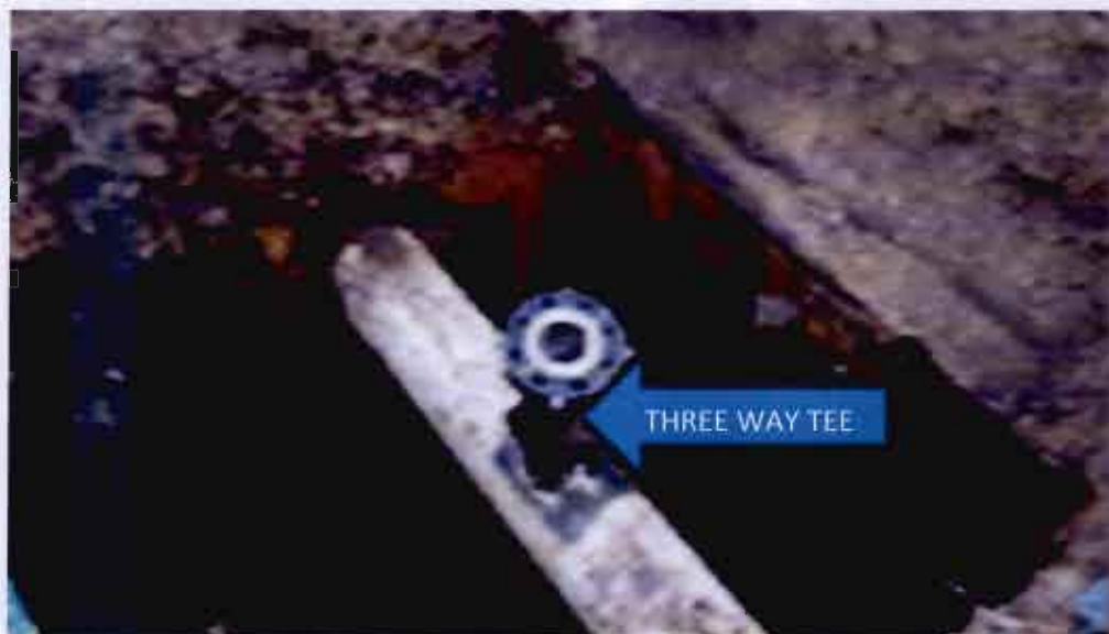
Uso accesorio "SPHERICAL THREE WAY TEE". Numeral 6.3 UCADE 6.
