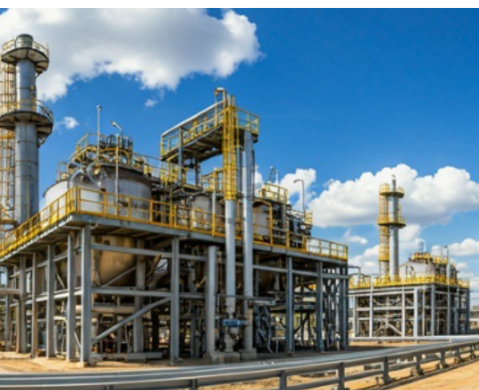
Figura 2 Suministro de gas combustible
