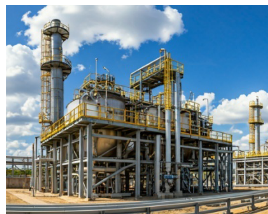
Figura 3 Sistema de Distribución
